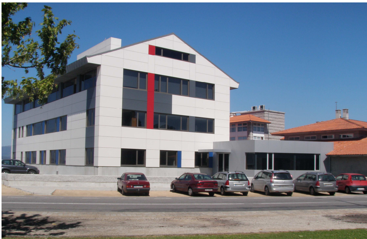
Imaxe 1. O novo edificio anexo veu dobrar a superficie útil do INTECMAR
